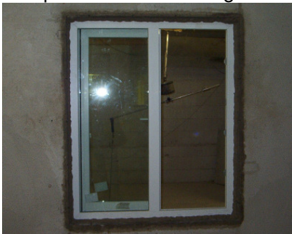
Bild 1 Foto des eingebauten Elementes, erstellt vom ift Schallschutzzentrum
